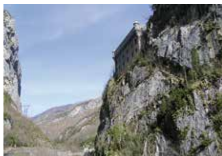
Fig. 8. Vue de la façade du pavillon des officiers, depuis la route 134. Cliché Isabelle Warmoes
