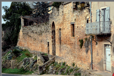
Fig. 3 – Vue de la portion sud-ouest des fortifications du XV e siècle.
