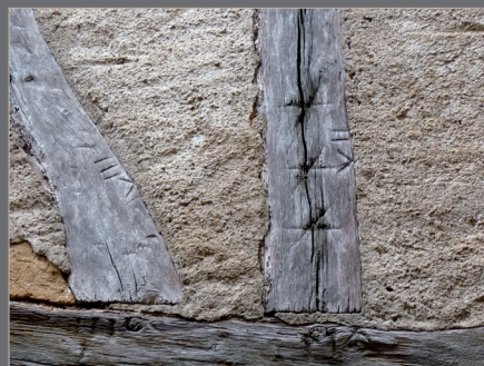
Fig. 7 – Détail de la numérotation des bois d'une façade.
